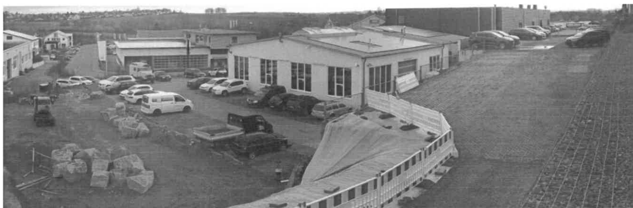
Abb. 5: Blick auf den Geltungsbereich aus östlicher Richtung.
